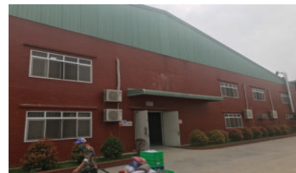
Tổn thất máy móc thiết bị và công trình kiến trúc do cháy
